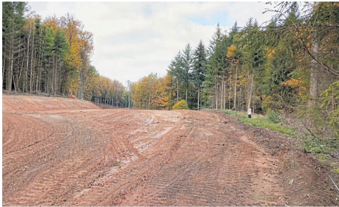
Kahlschlag durch den Gieseler Forst bei Fulda zwecks Straßenbegradigung.
