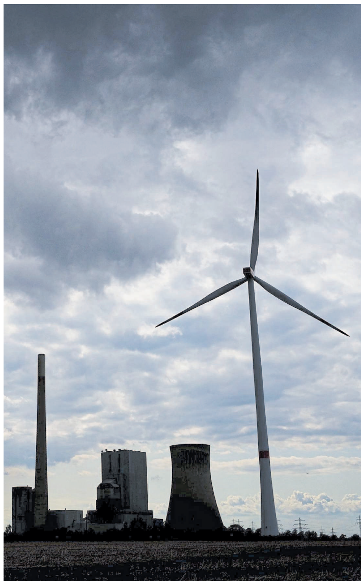
Das Kohlekraftwerk Hohenhameln in Niedersachsen, Wegen des Klimawandels wird das schnelle Aus für Kohlekraft gefordert. DPA
